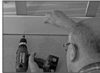
Erstes Steck-Paneel befestigen
