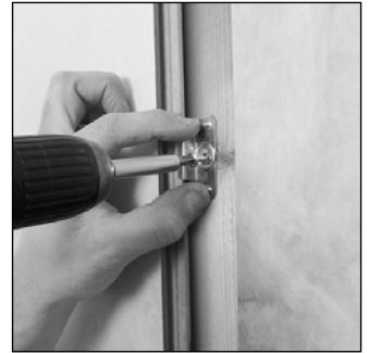
Mittelklammer setzen
