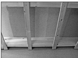
Unterkonstruktion
