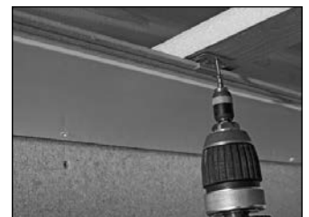
Befestigungskralle anschrauben
