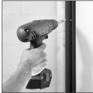
Befestigungsschiene setzen
