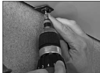
Leistensclip montieren
