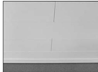
Deckenabschlussleisten aufstecken – fertig
