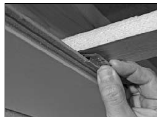
Befestigungskralle setzen
