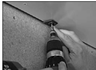
Leistensclip montieren
