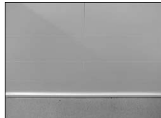
Deckenabschlussleisten aufstecken – fertig
