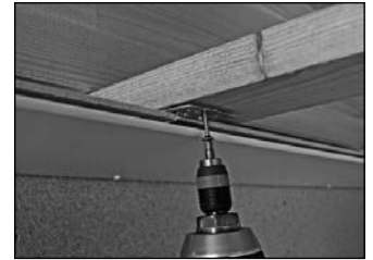
Befestigungskralle anschrauben
