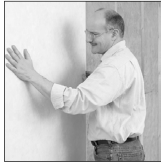
Einsetzen erste Platte
