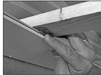
Befestigungskralle setzen
