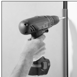
Befestigungsschiene letzte Platte
